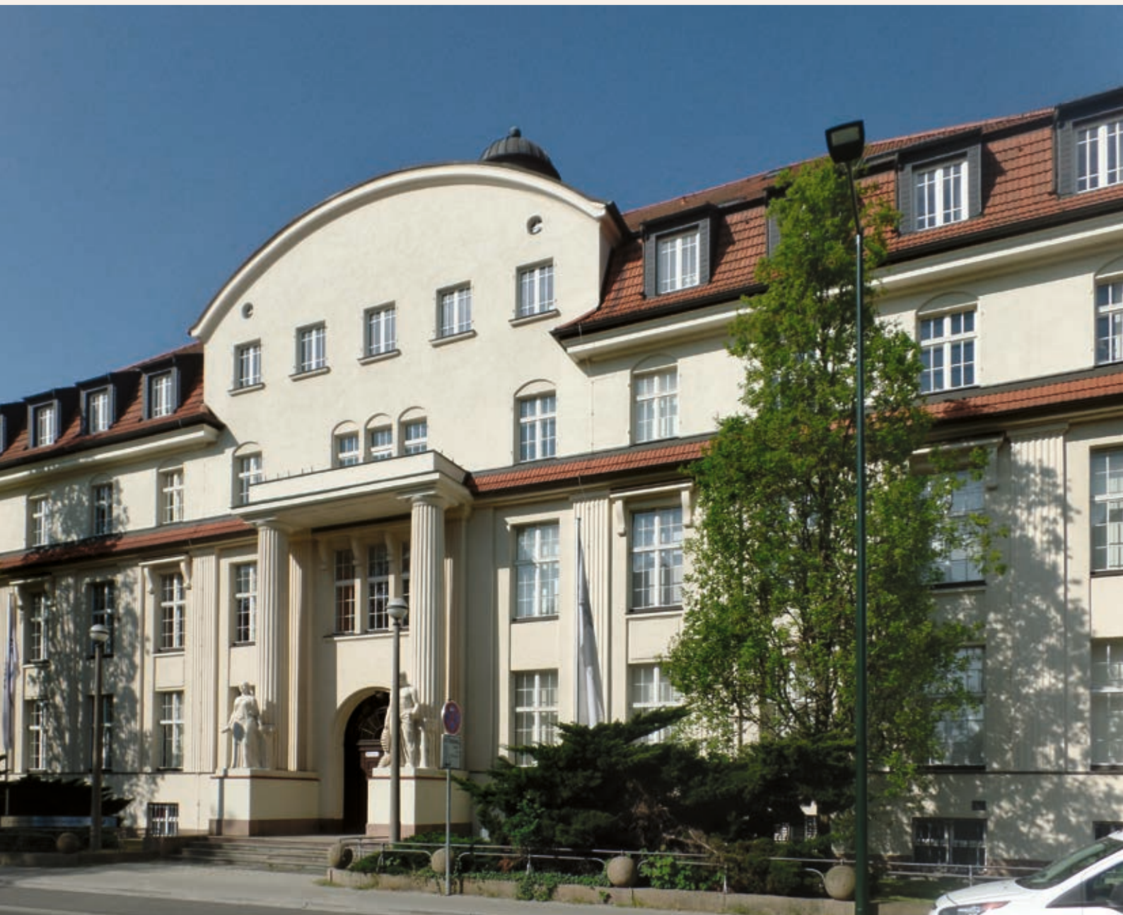
Die Energie in der Friedrich-Ebert-Straße 26
