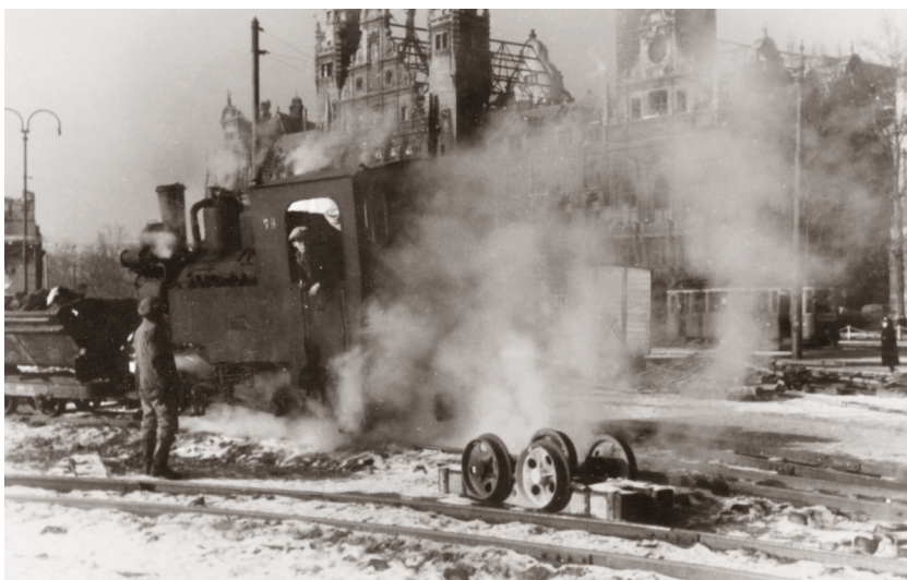
Trümmerbahn auf dem Wilhelm-Leuschner-Platz
