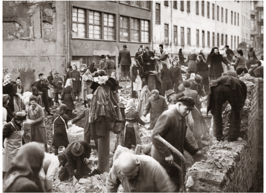
Aufräumarbeiten im Böttchergäßchen
